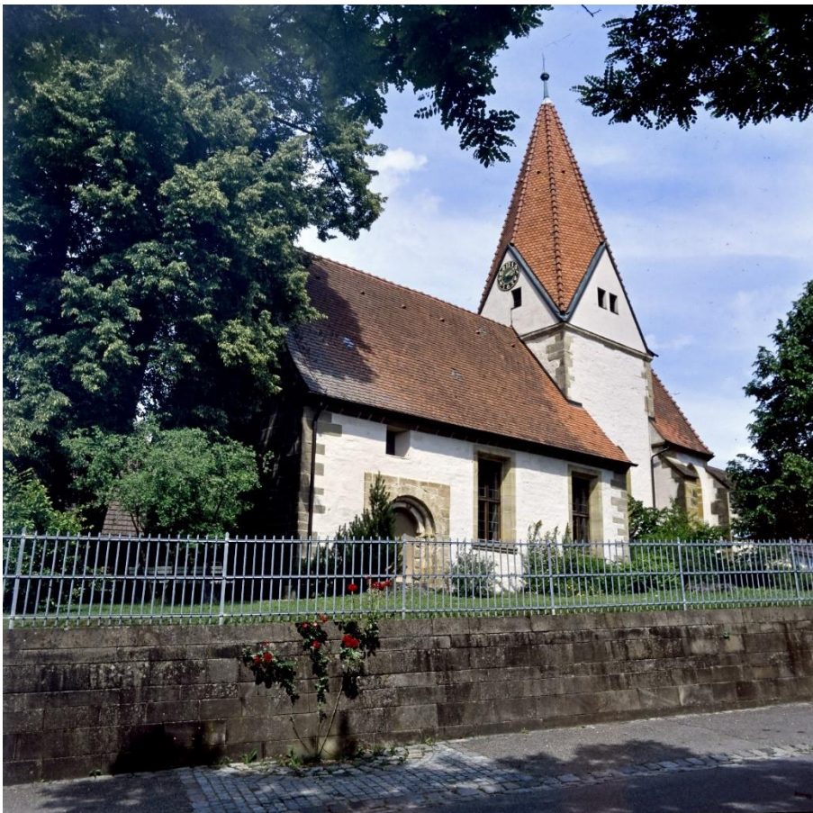
Blick auf Süd- und Westseite.
