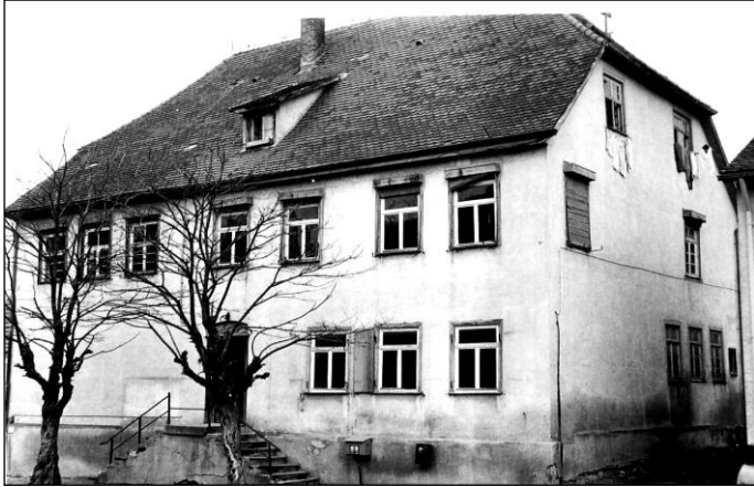
Oberböbinger Rathaus und Schulhaus, abgebrochen 1976.
