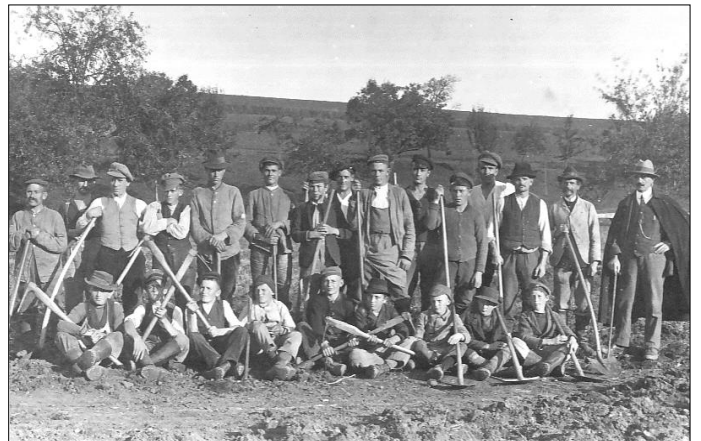
Arbeiter beim Bau der Bahnstrecke in Oberböbingen
